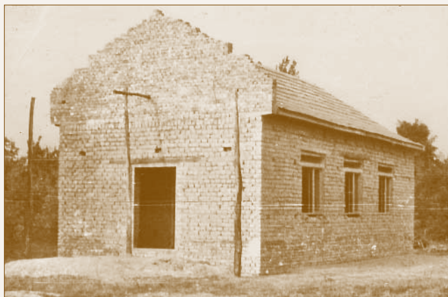
Az épülő parókia
