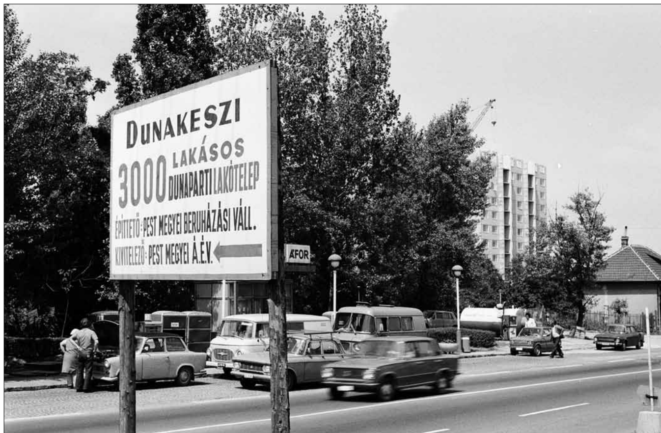
A Fő úton tábla hirdeti a „Dunaparti”, ma Barátság úti lakótelep építését. Az út túloldalán az 1961-ben átadott (még ma is üzemelő) benzinkút látható. A háttérben a Barátság útja 3. számú ház legfelső szintjeinek panelelemt emeli be a daru.
