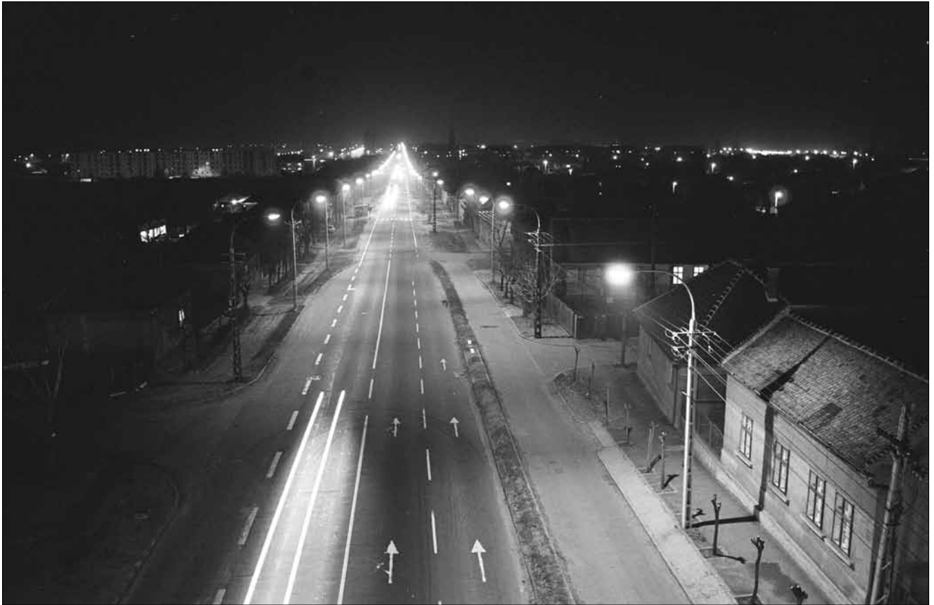
A Fő (akkor Tanácsköztársaság) út esti kivilágításban. A háttérben balra a Tallér utcai lakótelep frissen átadott tömbje.
