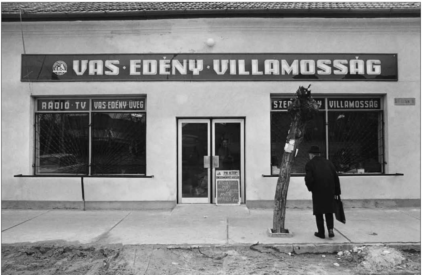
A feni kereszteződés harmadik sarkán álló egykori ún. Vasbolt, melynek felújítása épp a várossá avatás napjára készült el. A rendszerváltás után kínai ruhaüzletként is üzemelt, ma használaton kívül pusztul.
