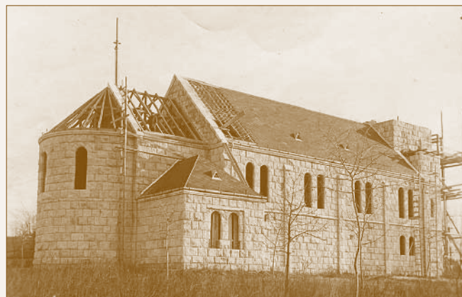
Az épülő templom 1936-ban
