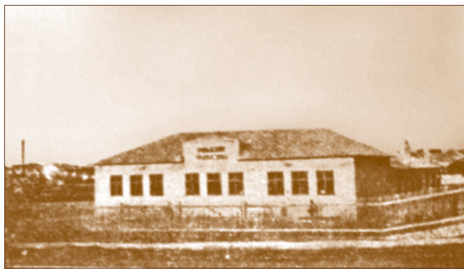
A polgári iskola épülete a Lajos utcában
